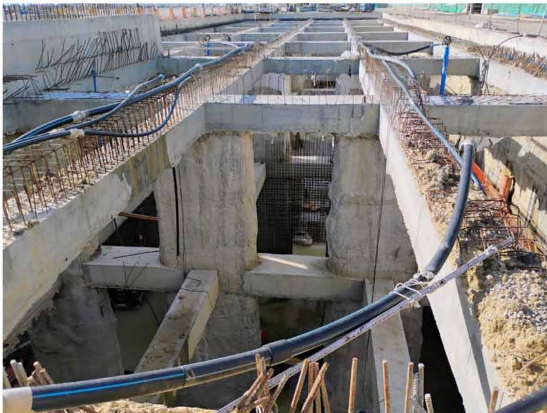
Obras del tanque anticontaminación. - viva
