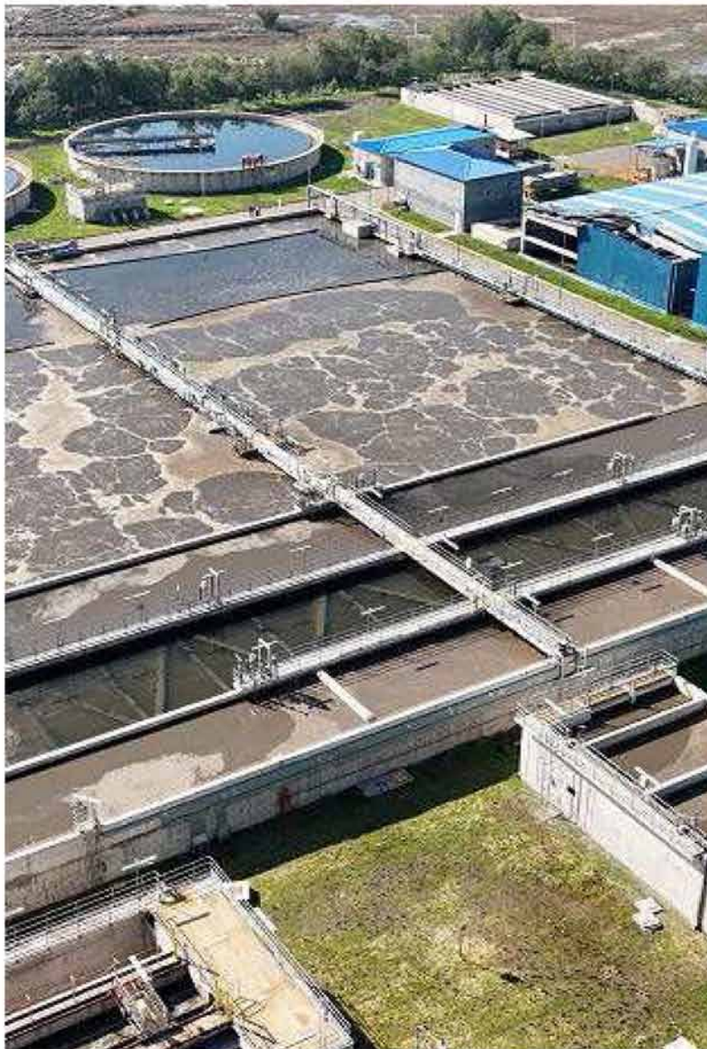
La planta de La Cadellada trata el agua residual generada en la zona de Colina.
